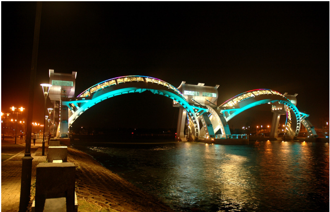
照片二 三岔河河口闸夜景
